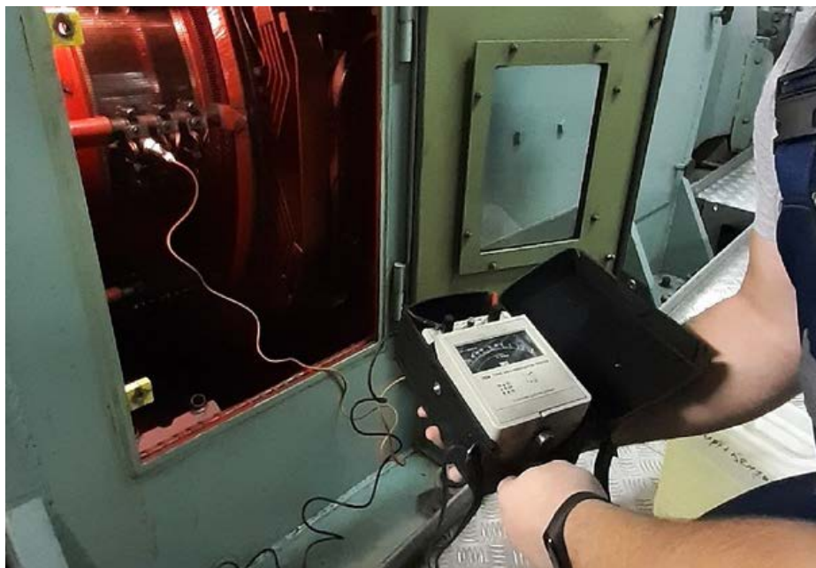
Рисунок 3 – Замер изоляции коллекторного механизма
