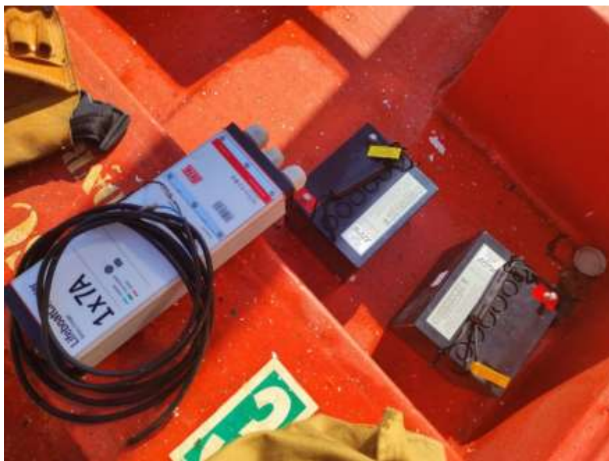
Рисунок 2 – Техническое обслуживание аккумуляторных батарей дежурной шлюпки
